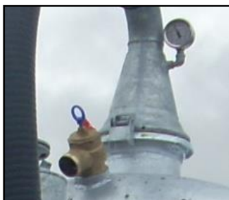
Varoventtiili 1" ¼ Kalibrointipaine 0,8 bar
