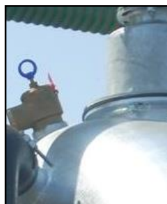
Varoventtiili 2" Kalibrointipaine 1 bar
