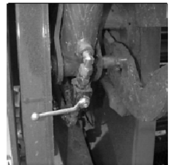
Kuva 38 - Sulkuventtiili
