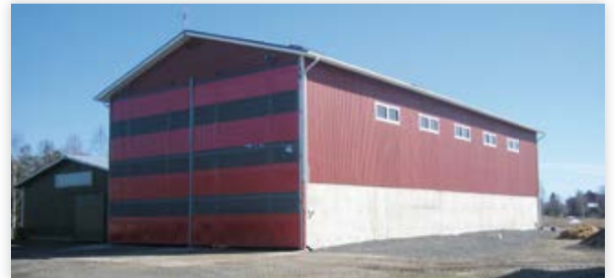
5. Viimeiseksi asennetaan aluskate, kattopellit ja räystäslaudat sekä ovet ja ikkunat
